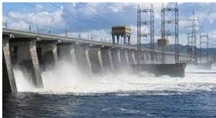
На гидроэлектростанциях (ГЭС) и гидроаккумулирующих электростанциях (ГАЭС) используется потенциальная энергия воды, накапливаемая с помощью плотин. У основания плотины расположены гидротурбины, приводимые во вращение водой и вращающиеся роторы генераторов электрического тока.
